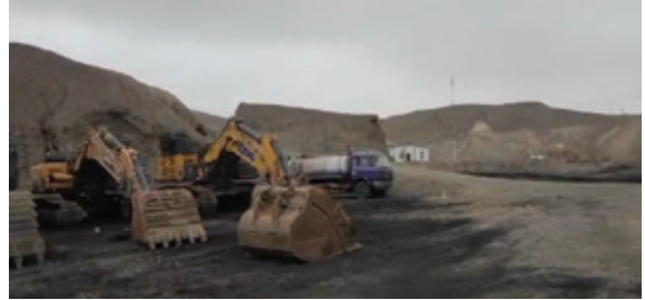
灭火工程将以剥挖及平整形式进行
